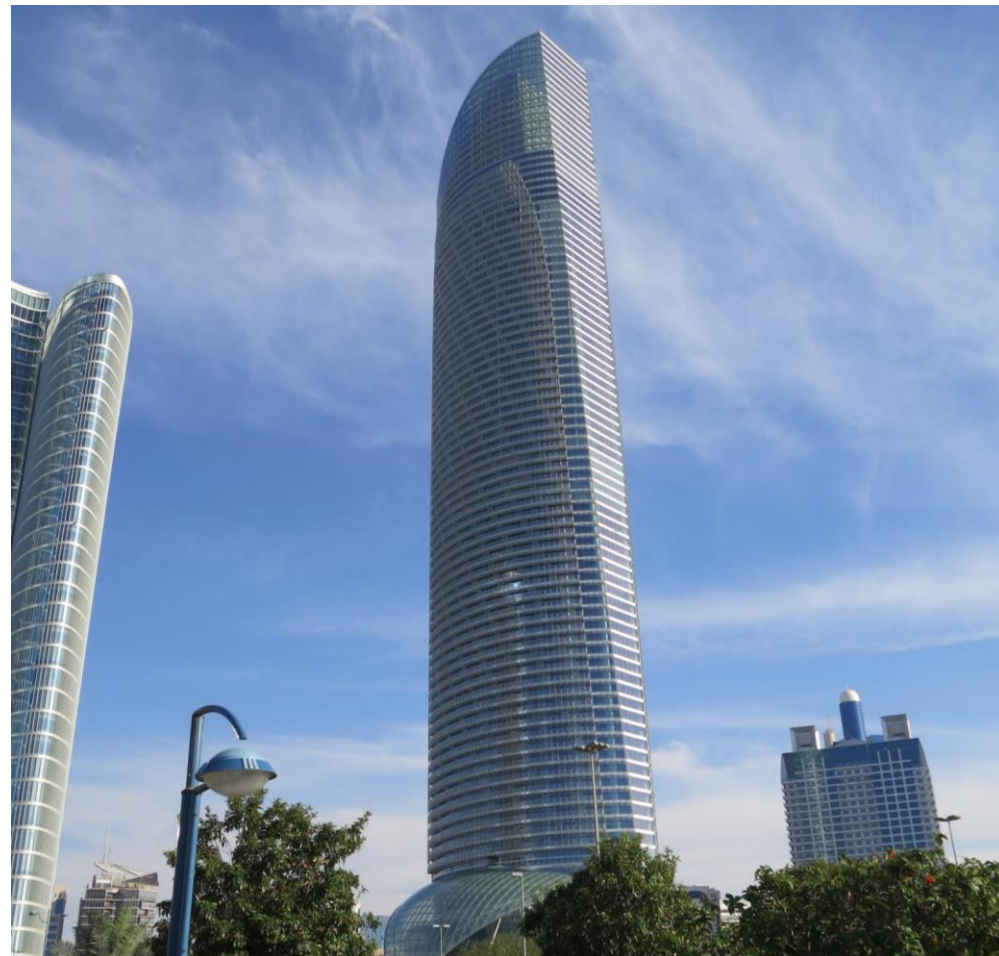
Landmark Tower – Elementfassade mit integriertem Sonnenschutzsystem
