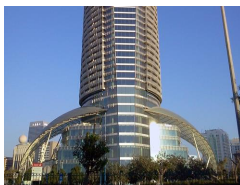
Ansicht mit Vordach im Bau, Februar 2013
