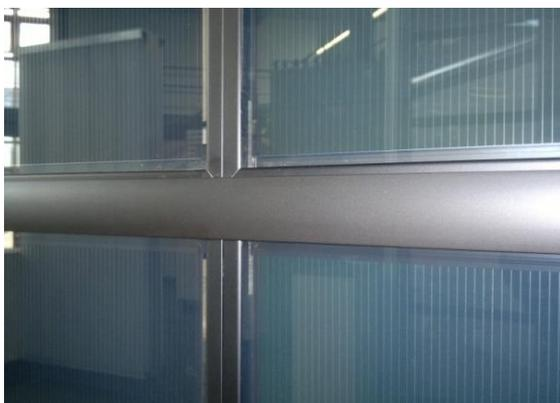
Detail der Module mit Inlay Schienen Detail of modules with Inlay rails
