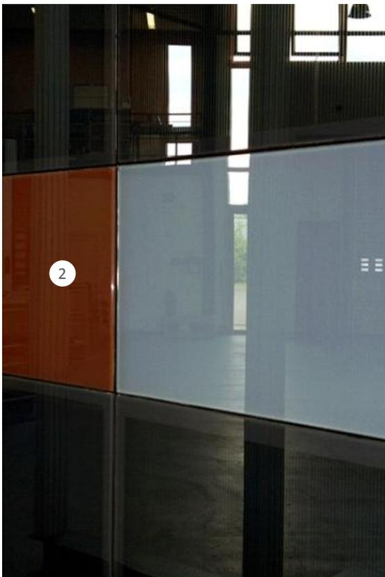
Detail mit farbigen Modulen Detail of coloured solar modules
